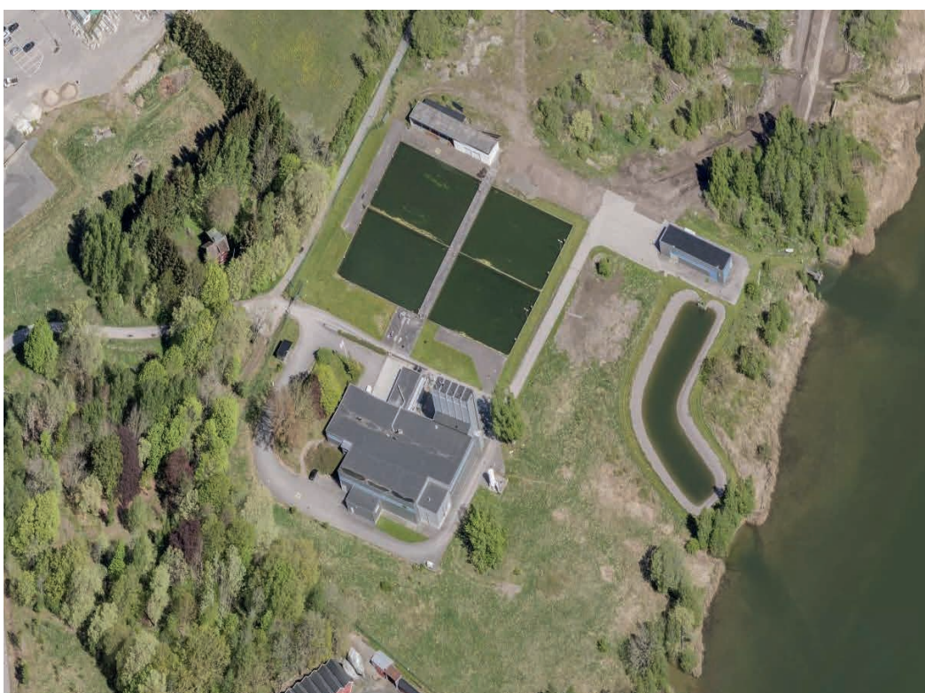
Flygbild över befintligt vattenverk, 2020.
